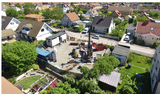
Figur. Kärnbörning ner till 70 meters djup i källzonen på Blekingegatan 2019. Den sedimentära berggrunden i Helsingborgsområdet utgör en betydande grundvattenförekomst med stor utbredning och flera olika grundvattenmagasin. Dessa nyttjas bland annat som reservvattentäkt vid Helsingborgs sjukhus cirka 500 meter nedströms området och vid Ramlösa för bordsvattentillverkning några kilometer söder om Blekingegatan.
