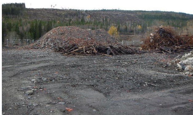
Några högar med utsorterad tegel/betong och armering, är det enda som återstår av spritfabriken.
