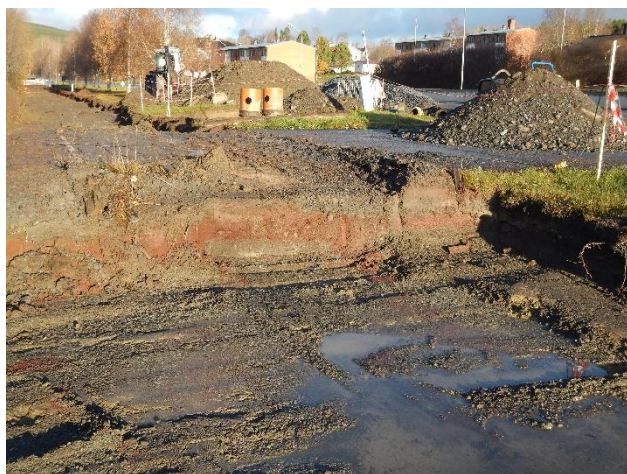
Kisaskan syns som ett rödbrunt skikt i spårområdet, en rest från att man en gång i tiden ville förhindra ogräs.
