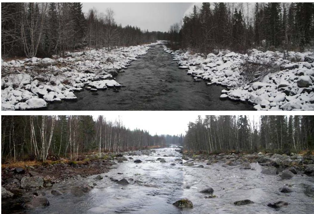
Figur 5. Kanaliserad forssträcka i Gargån, ett biflöde till Vindelälven, före (ovan) och efter (nedre) restaurering. Strömhastigheten sjunker efter restaureringen och vattenvolymen ökar. Fotograf: Niclas Hjerdt.
