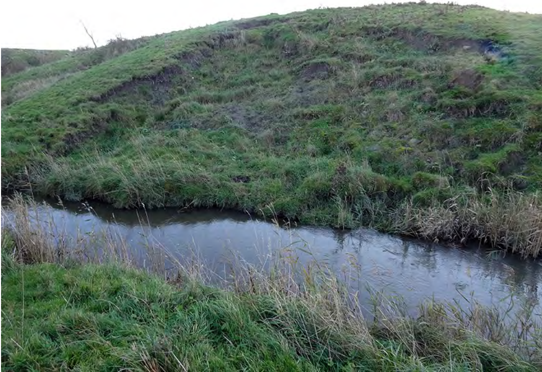
Figur 147. Skred i strandbrinken i Lillån, Kungsbacka. Orsaken är en kombination av finkorniga jordarter, högflöden i vattendraget, frånvaro av naturlig kantzon, vattenmättad mark och tramp från kreatur. Att stängsla bort kreatur skulle undvika överdriven erosion. Foto: Erik Degerman.
