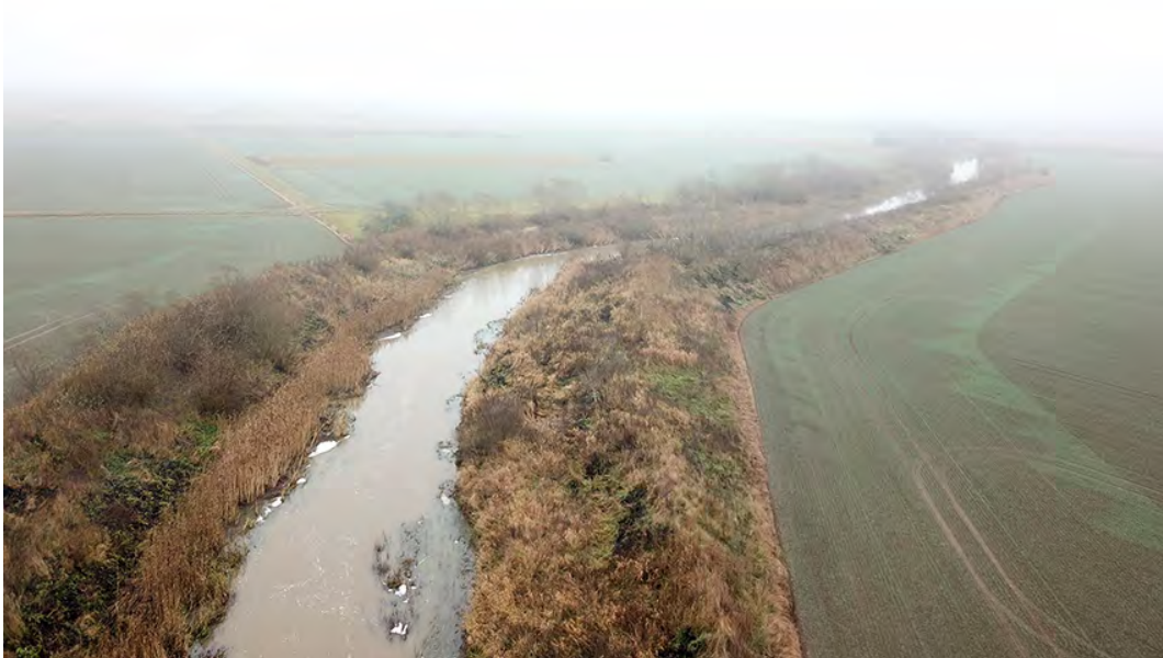
Figur 135. Täljeån på Närkeslätten rätades och kanaliserades och heter numer Kvismare kanal. De massor som grävs ur vattendraget läggs successivt på strandvallen och vattendraget blir djupare och förlorar kontakten med det allt högre och avlägsnare svämplanet. Foto: Erik Degerman.
