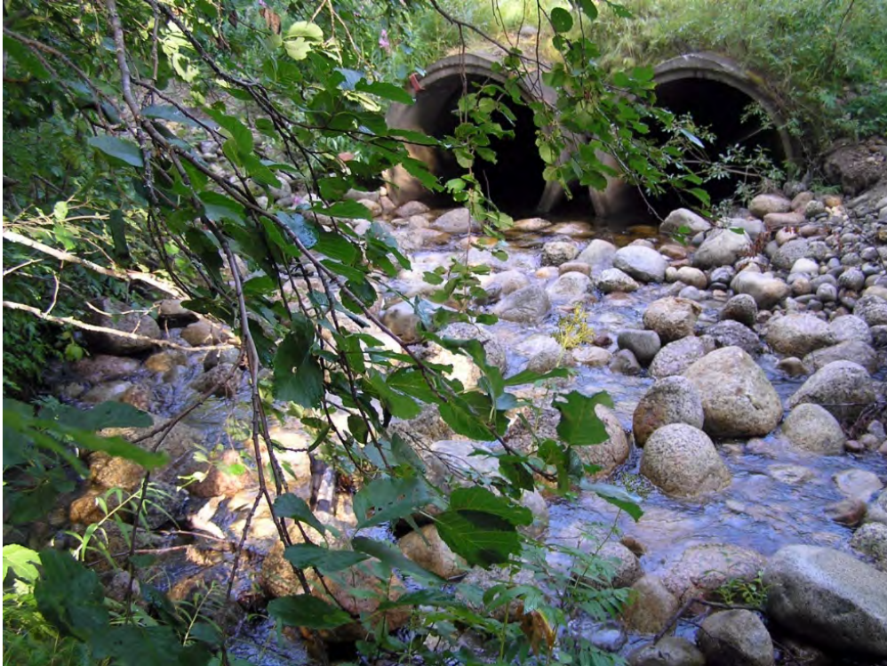
Figur 132. Tröskling nedströms vägtrumma för att minska vattenhastigheten och få nedströms vatten att direkt ansluta till trumman utan fall. Vid låg vattenföring, som på bilden, blir dock en tröskel nedströms ett hinder för större fiskars passage om inte en tydlig fåra skapas. Foto: Erik Degerman.
