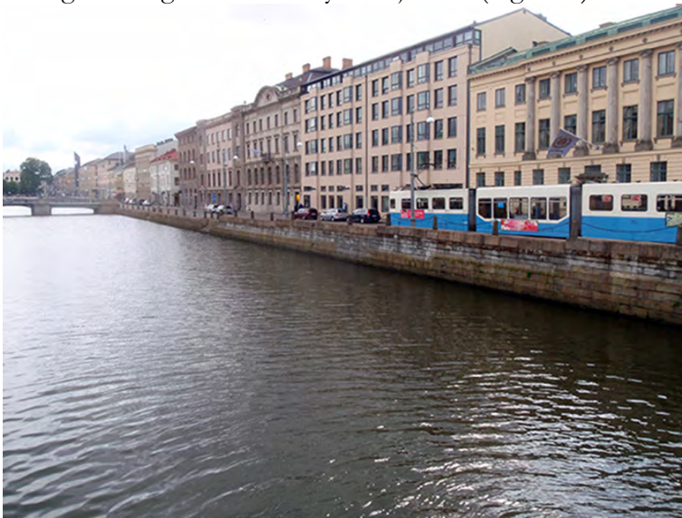
Figur 77. Mölndalsån i Göteborg. Ett kanaliserat vattendrag som har till funktion att föra undan vattnet, säkert och utan risk för översvämning. Syftet skulle nog också kunna uppnås med en ökad mångformighet i vattnet (då menar vi inte varukorgar och cyklar).
