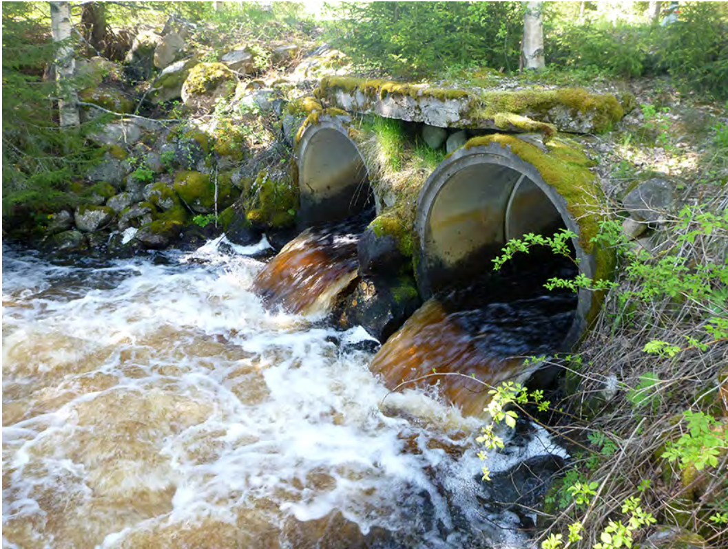
Figur 124. Bra tänkt att ha stor kapacitet med två trummor, men inte ens vid lämpliga flöden verkar det enkelt för fisk att komma uppströms. Även om de klarar hoppet så landar de på en slät botten med hög vattenhastighet. Foto: Pierre Samuelsson.
