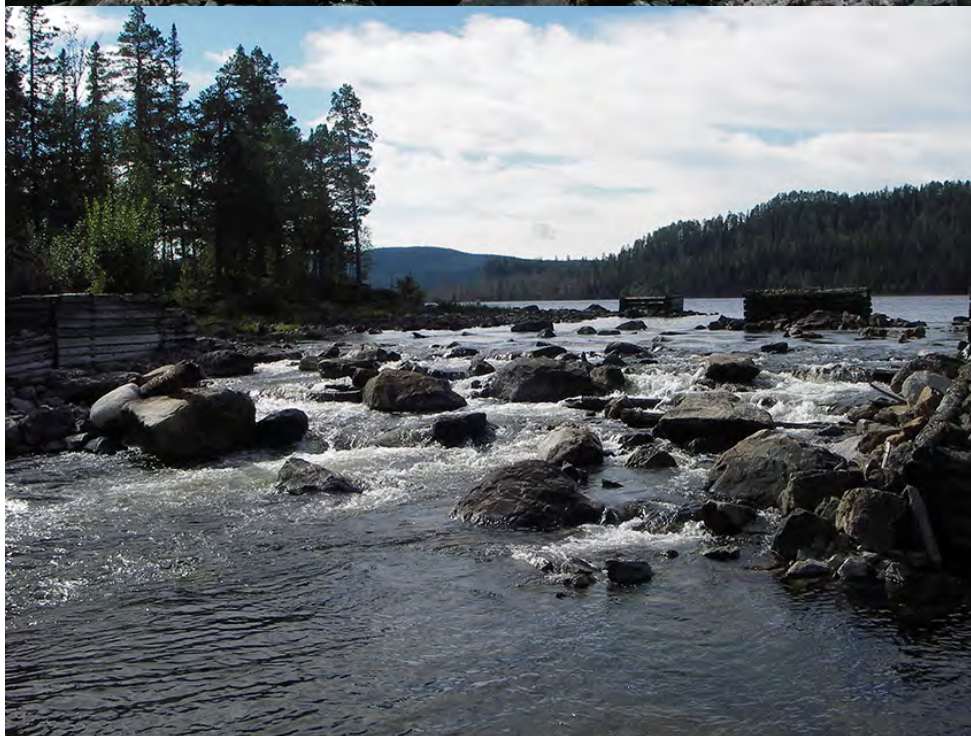
Figur 114. Utrivning av dämme i Svaningsån, Strömsunds kommun. Foto: Gunnar Jacobsson.
