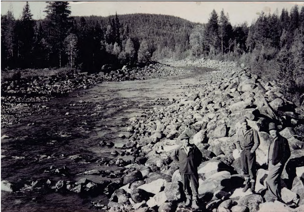
Figur 1. Flottledsrensad sträcka av Öreälven, Västerbotten. Med bandschaktare, som blev vanliga i början på 1950-talet, kunde arbetet göras storskaligt. Mot slutet av 1950-talet kunde det dock hända att dåvarande Vattendomstolen inte alltid gav tillstånd till "traktorrensningar".
