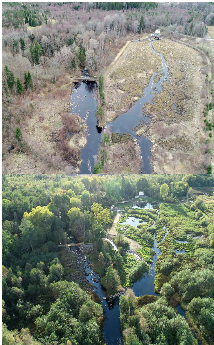
Figur 110. Utrivning av dämme och kraftverkets turbiner vid Hanefors, Aggån i Växjö kommun. Övre bild före åtgärd 2019-04-10, men med dammen avsänkt. Undre bild efter åtgärd 2020-10-13. Våtmarker och kvillar har återskapats, området har tillgängliggjorts (dammen har ersatts av en bro). Foto: Peter Lindvall, Jönköpings Fiskeribiologi AB. Fotona får spridas efter tillstånd av Lantmäteriverket.
