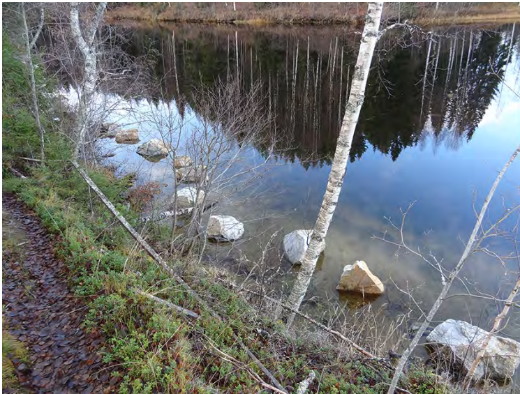
Figur 99. Utläggning av en skyddande ridå av stora stenar vid Granö, Umeälven. En metod som testas av forskare vid Umeå Universitet är att skydda finkorniga sediment utmed stränder från effekter av korttidsreglering i den kraftigt utbyggda Umeälven. Foto: Erik Degerman.
