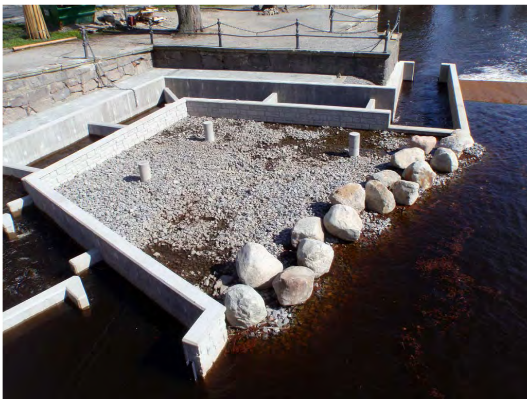
Figur 122. Slitsränna vid Slottet i Örebro, Svartån. Vyn är nedströms. Genom de smala slitsarna (enkelslits) ska fisk vandra. Funktionskontroller har visat att bland annat benlöjor passerar fiskvägen som är en passage runt ett lågt dämme (skibord) mitt inne i Örebro. Foto: Erik Degerman.
