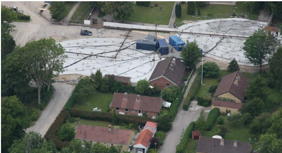
Figur 28. Foto över termisk behandling i Danmark, Krüger.
