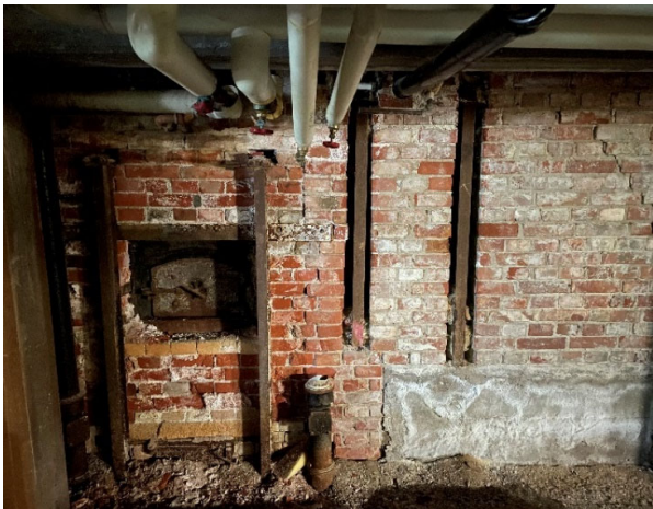
Figur 4: Källare västra väggen, provpunkt 21GA802.
