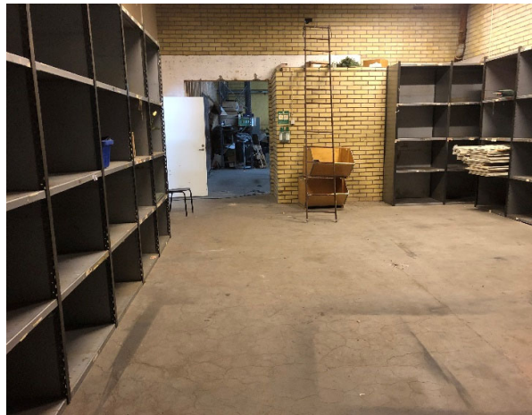
Figur 5: Lastningsyta södra delen markplan, provpunkt 21GA805 (betongplatta) samt 21GA806 (tegelvägg)
