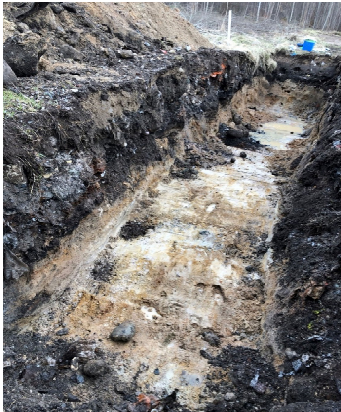
Figur 7: Provschakt 21GA306 i södra delen av utfyllnadsområdet, vy från södra änden av schakten
