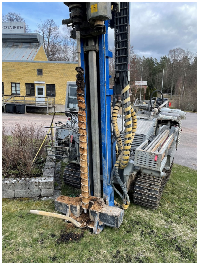
Figur 3: Skruvprovtagning i provpunkt 21GA208 sydväst om det f.d. glasbruket
