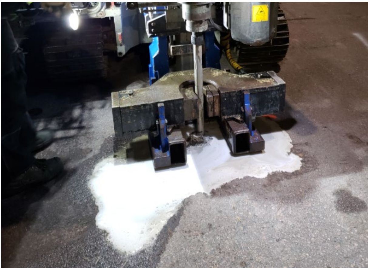
Figur 7 Uppträngning vid injektering i punkt F2-18
