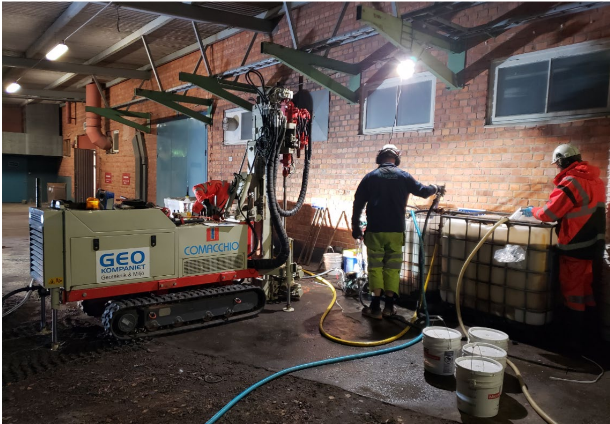
Figur 4 Injektering med "rigg 3"
