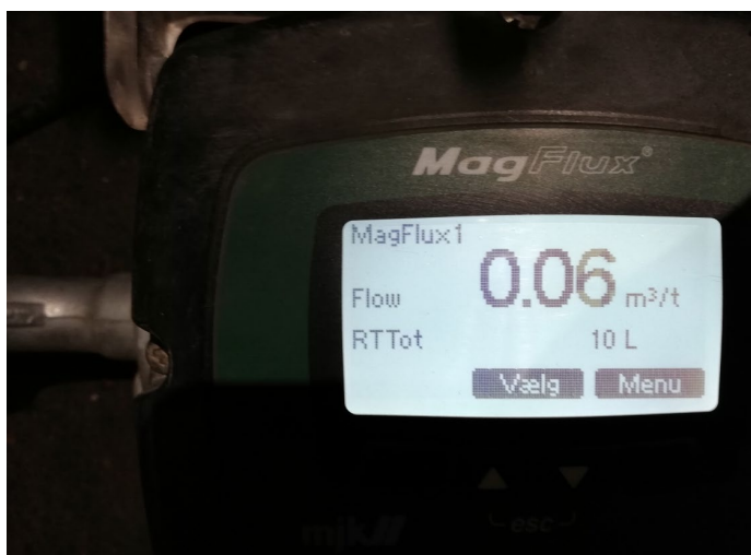
Figur 3 Foto på den induktiva flödesmätaren som monterades på slangen mellan blandningskärlet och rigg 3.
