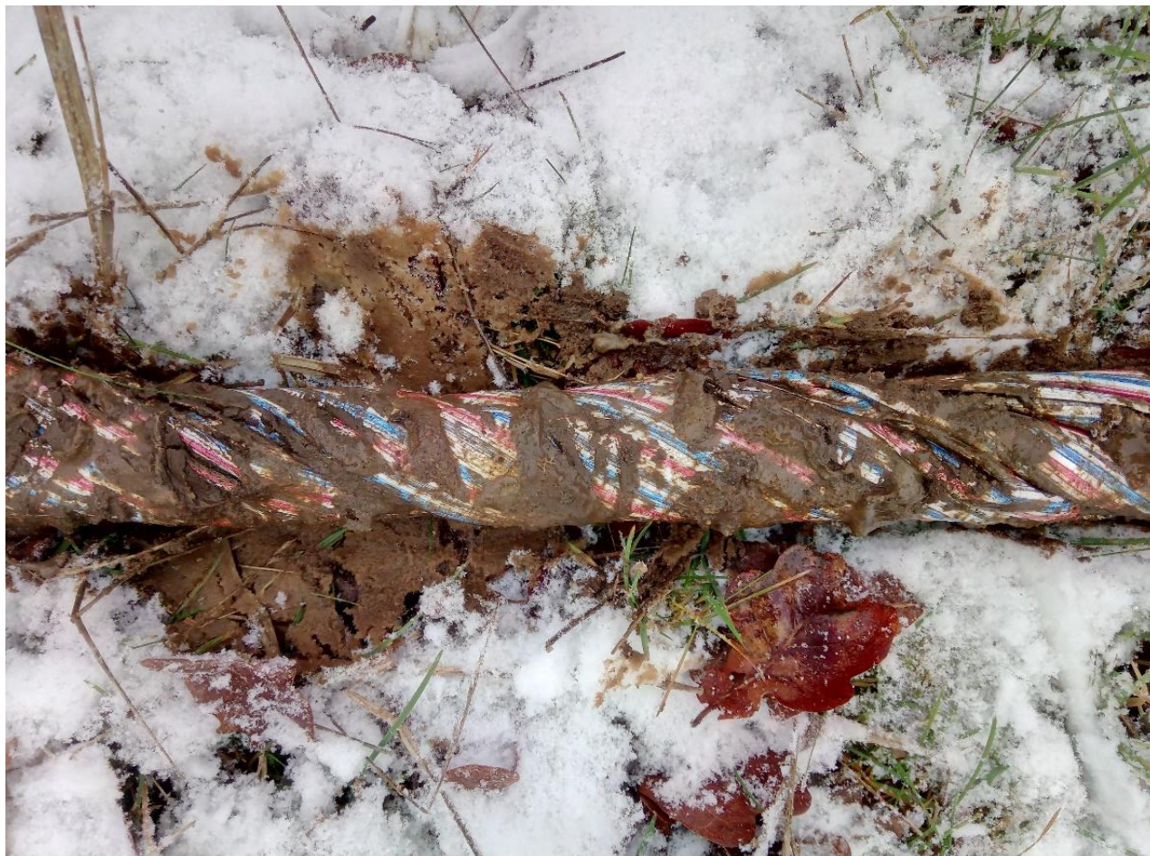
Figur 6.1: Kraftigt vriden liner efter avinstallation i NI1803 (utanför testområdet).
