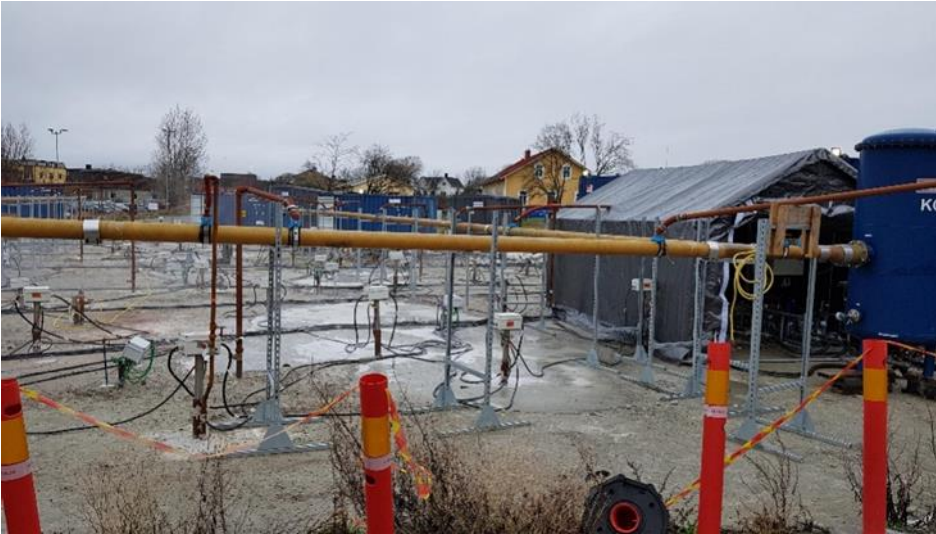
Figur 9. Bilden visar område inom vilket termisk åtgärd pågår. Ytan är tätad med betong.
