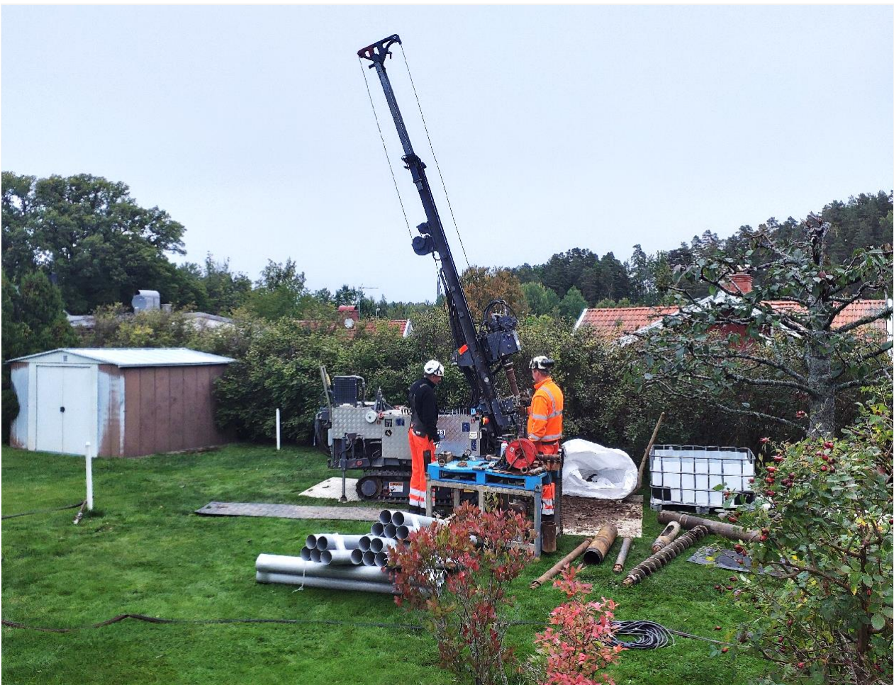
På bilden utförs kärnborring i berg med metoden Geobor S
