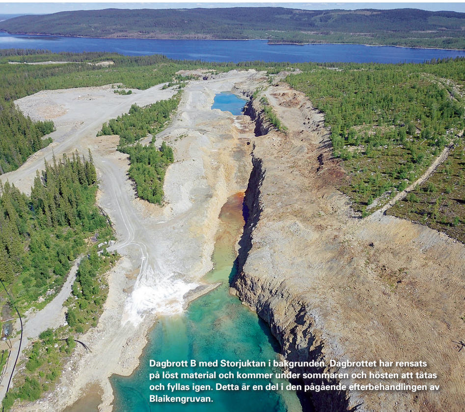
Arbetet med att tömma dagbrott B på vatten, sten och grus har pågått under våren och försommaren.
