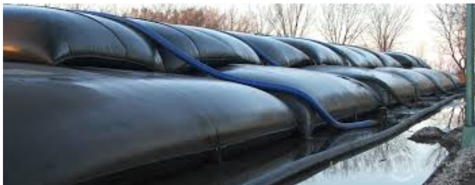
Figur 1. Exempel på upplagsyta för avvattning med sedimentfyllda geotuber.
