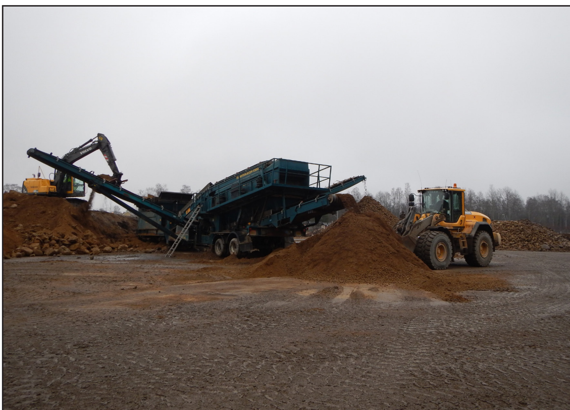
Figur 1. Sortering av schaktmassor vid Lessebo f.d sågverk.
