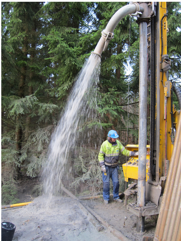
Figur 9. Den rigg som används för borrning är både stor och tung. Det är viktigt för entreprenören att iaktta försiktighet för att minimera skadorna, särskilt på känslig mark. Det är också viktigt att hålla utrustningen i gott skick för att förhindra läckage av olja eller diesel.
